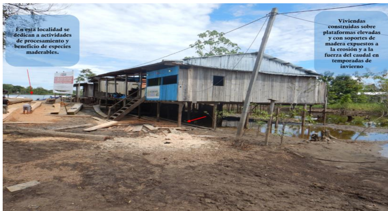
FIGURA N°03: VIVIENDAS CON SOPORTES DE MADERA EXPUESTA A EROSIÓN E INUNDACIÓN FLUVIAL
