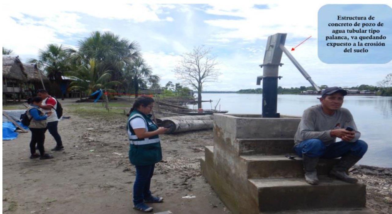
FIGURA N°02: ESTRUCTURA EXPUESTA A EROSIÓN FLUVIAL
